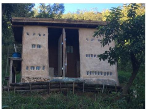
O princípio geral consiste na aplicação de pelo menos duas camadas sobrepostas. A primeira tem 2 cm a 3 cm de espessura e é feita com materiais de granulometria mais grossa; e a segunda camada, com alguns milímetros de espessura, é feita com materiais de granulometria fina.
