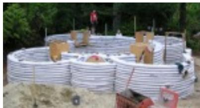
A técnica da terra ensacada, também chamada por “superadobe” é um processo construtivo, no qual sacos de polipropileno são preenchidos com solo argiloso e moldados no próprio local através do apiloamento do mesmo por processo artesanal.
