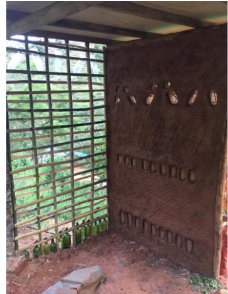
A diferença entre essas técnicas é que para fazer as paredes de pau a pique deve-se fazer uma trama com madeira ou bambu e ‘bater’ a massa diretamente na estrutura. O cob dispensa a trama porém as paredes precisam ser mais grossas para garantir uma boa sustentação do telhado. Já os tijolos de Adobe precisam de uma fórmula de madeira para sua produção, onde são criados os tijolos.
