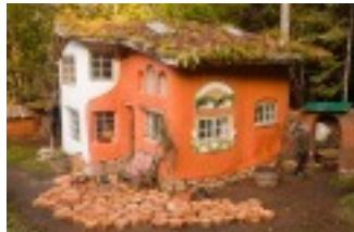
Cob é um material de construção composto por terra, areia e palha, similar ao adobe. O Cob é a prova de fogo, resistente a atividade sísmica e com custo quase nulo. Pode ser usado para criar formas artísticas e esculturais, dando liberdade às formas da bioconstrução.
