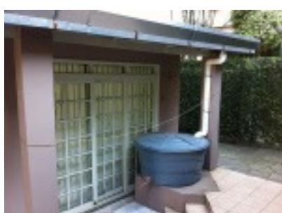
Esse modelo de captação normalmente é construído adaptado a telhados e redirecionado para cisternas construídas no subsolo da residência. A água armazenada pode ser utilizada para muitas coisas, inclusive para lavar a louça ou tomar banho. Para melhorar o seu uso é indicado construir um filtro de areia para que a água seja armazenada com menos impurezas na cisterna.
