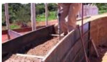
Esta tecnologia consiste em comprimir a terra em fôrmas de madeira no formato de uma grande caixa, denominadas de taipais, onde o material a ser socado é disposto em camadas de aproximadamente quinze centímetros de altura até atingir a densidade ideal, criando assim uma estrutura resistente e durável.
